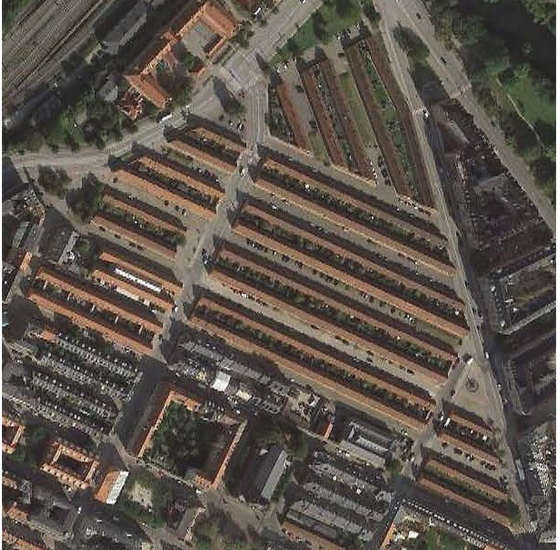
Abb. 18: Ehemaliges Marine-Wohnquartier Nybodergården aus dem 17. Jahrhundert in Kopenhagen (Dänemark) (Quelle: Googlemaps dtd. 08.09.2017)
